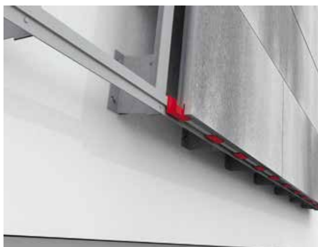
Obr. č. 6 Osazení obkladové desky do základních kotevních prvků
